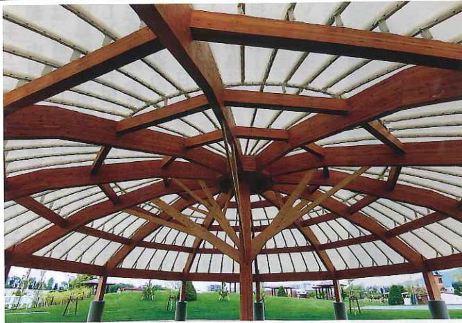
接合部が見えず、幕屋根の接合もボルト接合に比べ安定感が増す(はるにれドーム)
