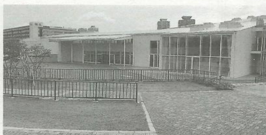
完成した江東区初の準耐火木造建築物の豊洲ぐるり公園パークレストラン正面
