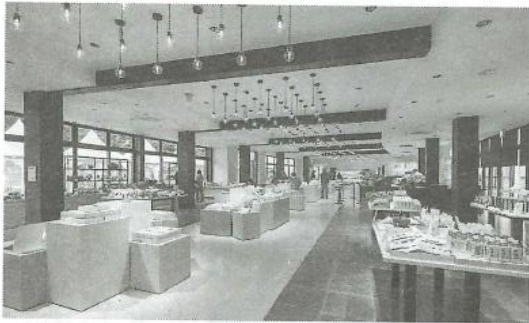
柱・梁だけで空間を構成でき、間仕切り部材や面材を自由に選べるのも魅力だ
