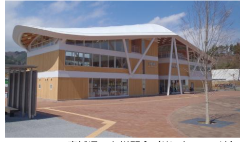
宮城県：女川駅舎（サミットHR工法）
